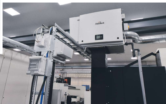
A.mist6C är Absolents mest kompakta filterenhet för smidiga och kreativa installationsmöjligheter. Till denna maskin har man placerat filterenheten på ett golvstativ för att inte störa driften av maskinen men samtidigt komma nära källan och kunna säkerställa ren luft för operatören.
