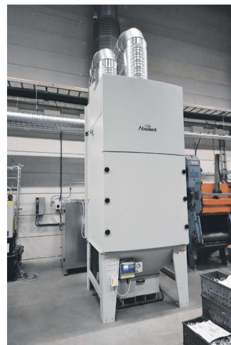
Absolents torrstofffilter A.dust15 med down flow teknik för lång och underhållsfri drift. Detta filtersystem tar hand om torra partiklar som i det här fallet uppkommer vid slipning, blåstring och trumling.
