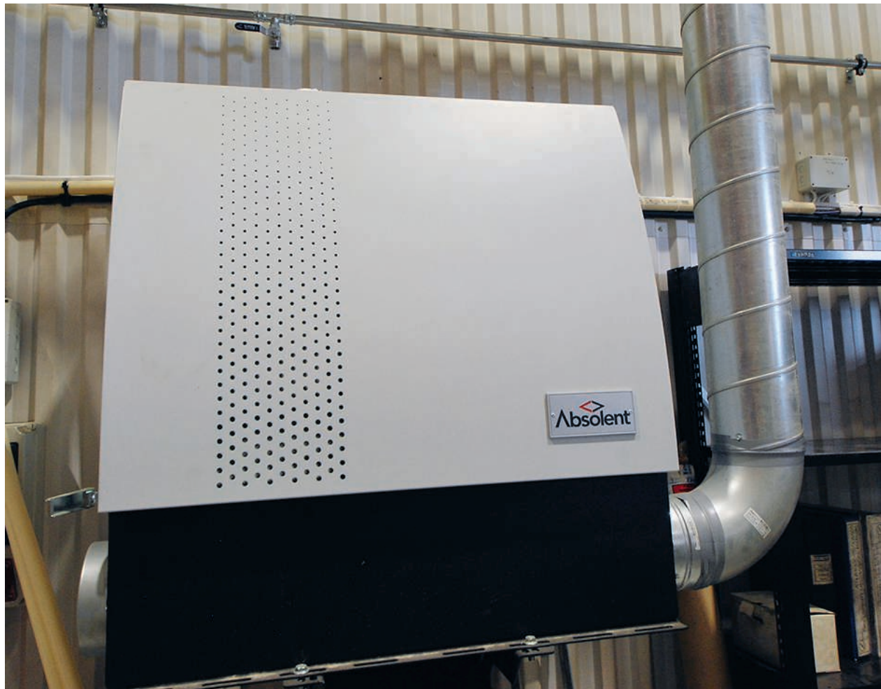
- Absolents oljedimfilter A*smoke är en av världens effektivaste utrustningar för rening av oljedimma. Centralfilterserien består av parallellkopplade moduler, som dimensioneras efter kundens luftflödesbehov. Fördelarna med centralfilter är billigare installation, enklare underhåll med färre servicepunkter, samt möjligheten att leda processluften till en värmeväxlare.
