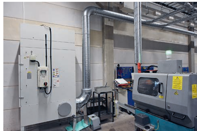
I en och samma verkstadslokal kan förutsättningarna variera kraftigt därför anser vi att det är viktigt med ett brett och flexibelt produktutbud. I denna del hos Industrilås passade det bäst med ett gruppfilter, A.mist40TF som med ett vätsketätt rörsystem besörjer flertalet maskiner. Detta och alla övriga filter hos Industrilås är installerade och driftsatta av Absolents egna servicetekniker Petter Lindh och Richard Ejdestig.
