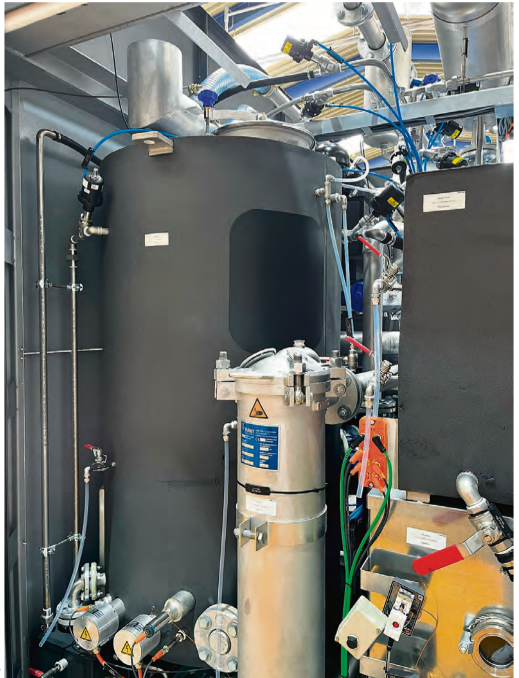
Konstruktionen och utrustningen av EcoCvario, med till exempel stående och strömningsoptimerade flottörbehållare och de speciella svetsade, medieförande ledningarna, är utformade för att uppfylla höga renhetskrav. Bildkälla: Ecoclean GmbH
